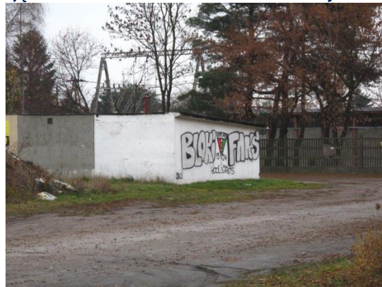
Zdjęcie 11. Garaże zlokalizowane w dzielnicy
