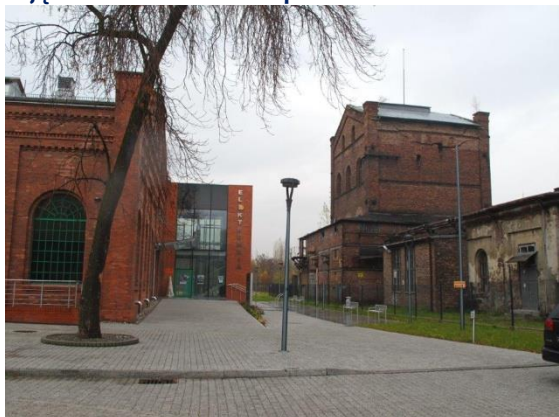
Zdjęcie 20. Zabudowa Kopalni Saturn
