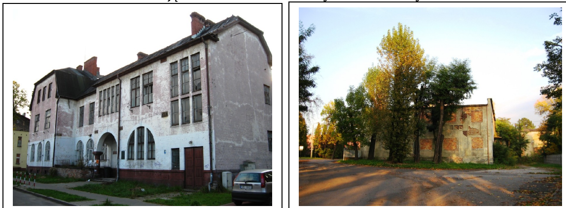
Zdjęcia 1 i 2. Zniszczone budynki oraz tereny
