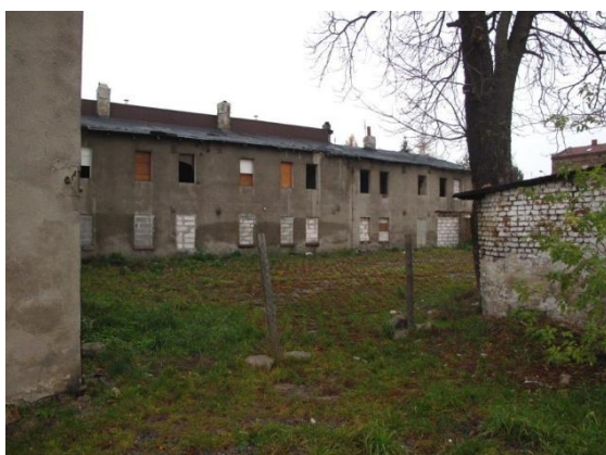
Zdjęcie 5. Pustostan ul. Bytomska 70 w strefie Stare Miasto
