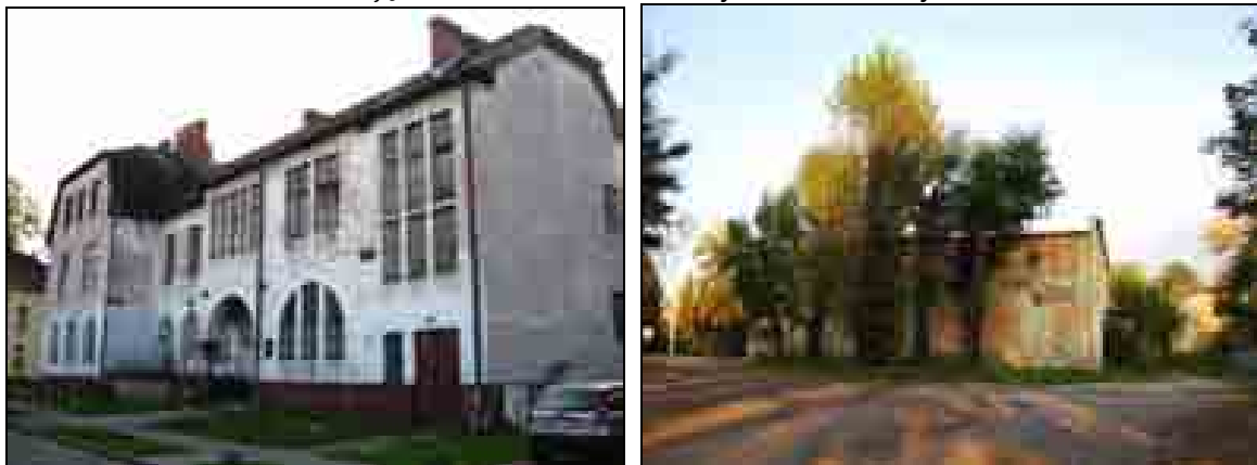
Zdjęcia 1 i 2. Zniszczone budynki oraz tereny
