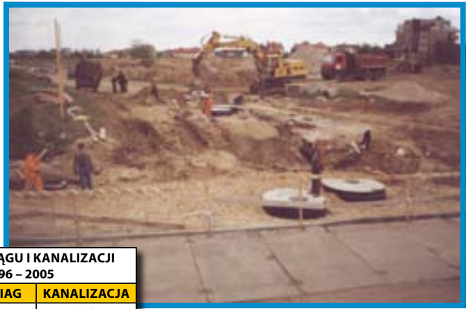
Powstaje kanalizacja sanitarna i deszczowa w ulicy Wiejskiej
