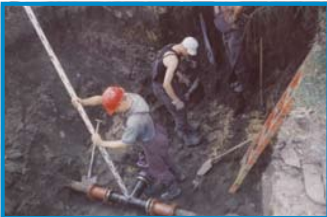
Na kilku metrach głębokości budowane jest przyłącze ulicy Jasnej do ulicy Dalekiej
