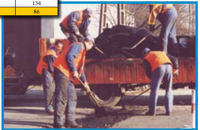
Roboty drogowe to częsty widok na ulicach Czeladzi – prace w ulicy Sadowej
