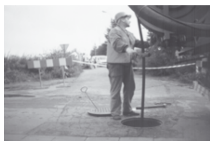
Prace na ulicy Sikorskiego
