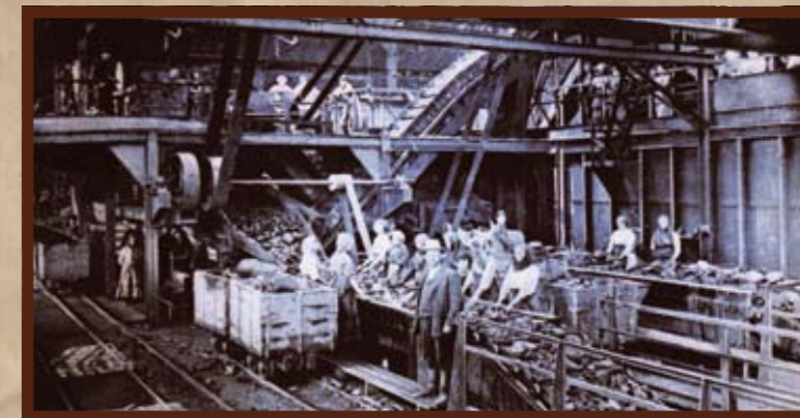
Praca w sortowni kopalni „Czeladź”. Piaski, ul. Kosciuszki 24, budynek Zakładu Energetyki Górniczej
