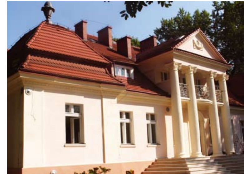
Front pałacu prawie gotowy – jeszcze trwają prace wykończeniowe
