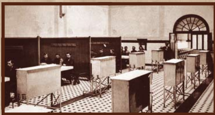
Jadalnia w Sokolni – budynek nie istnieje. Piaski, rondo, ul. Nowopogońska 222
