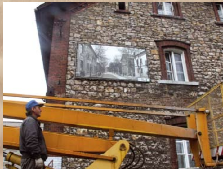
Montaż fotogramu przez ekipę ZIK przy ulicy 27 Stycznia
