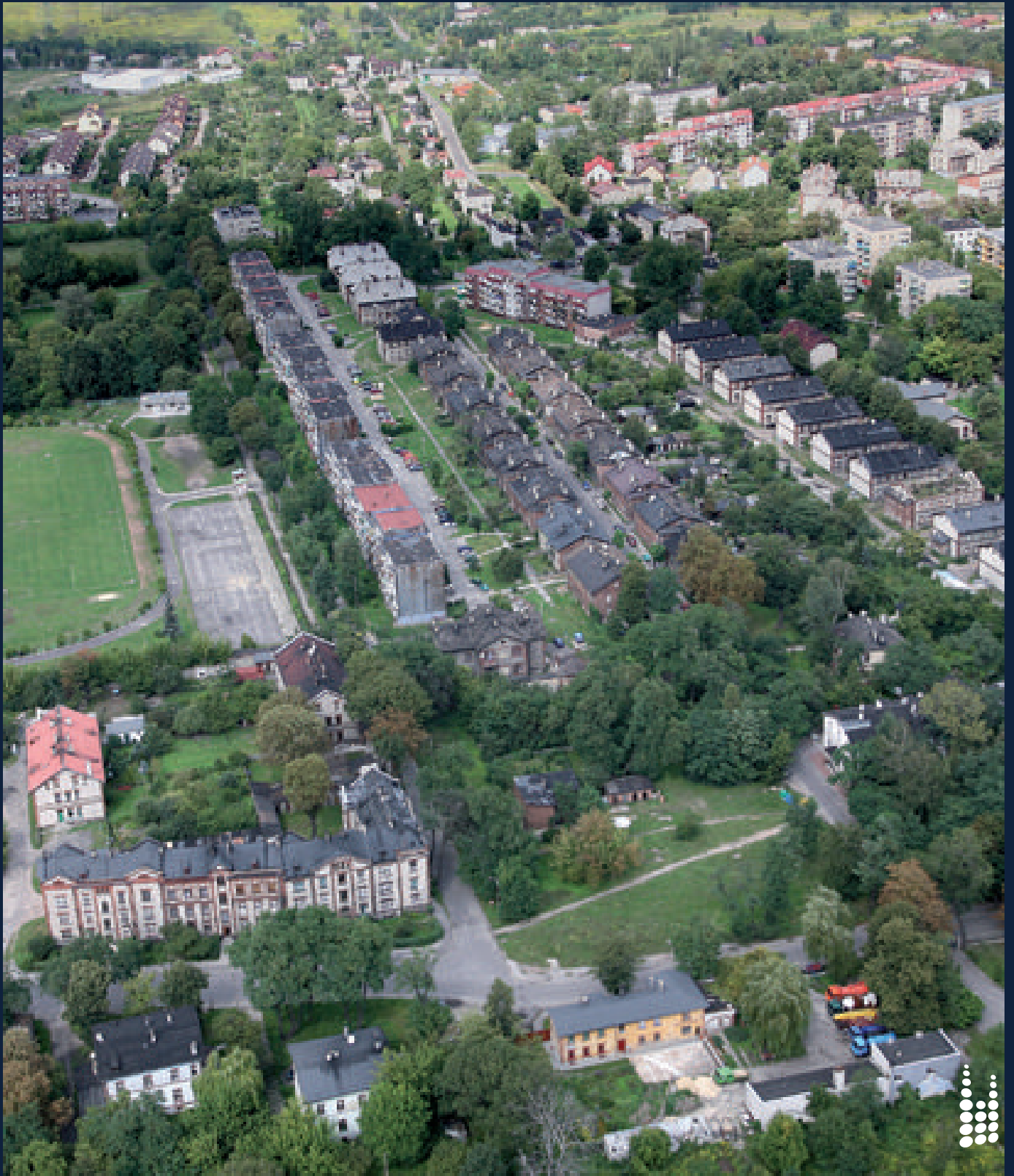
Unikatowe zabudowania mieszkalne kopalni „Czeladź” – na pierwszym planie narożna kamienica urzędnicza.
