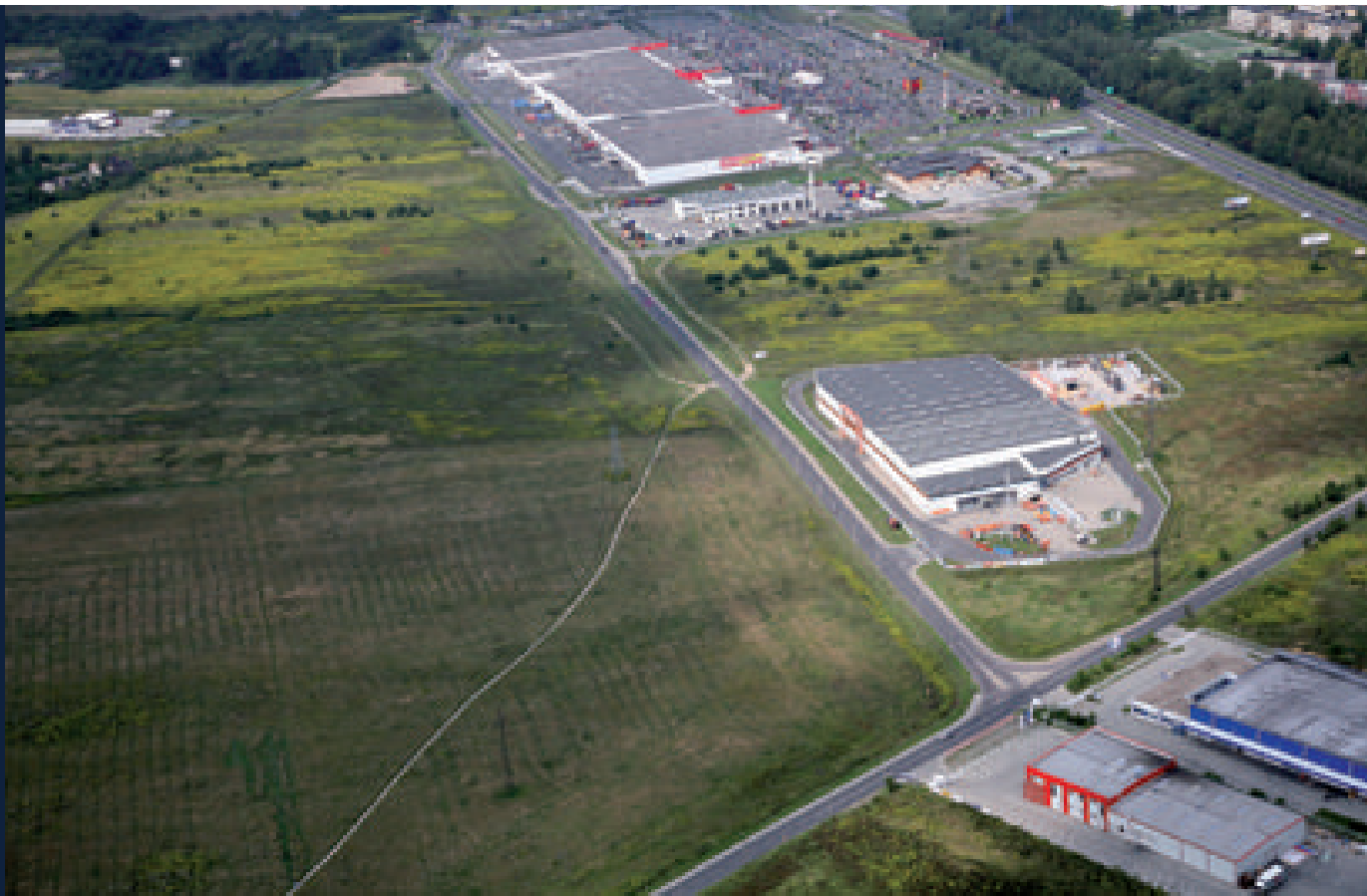
Wzdłuż ulicy Wiejskiej i Handlowej rozwija się Wschodnia Strefa Ekonomiczna. Wkrótce na niezagospodarowanym terenie powstanie kolejna inwestycja – centrum logistyczne.
