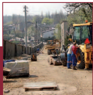
Roboty drogowe w ulicy Cmentarnej.
