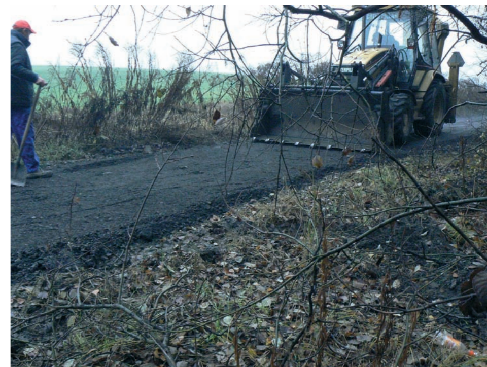
Powstają ścieżki rowerowe.
