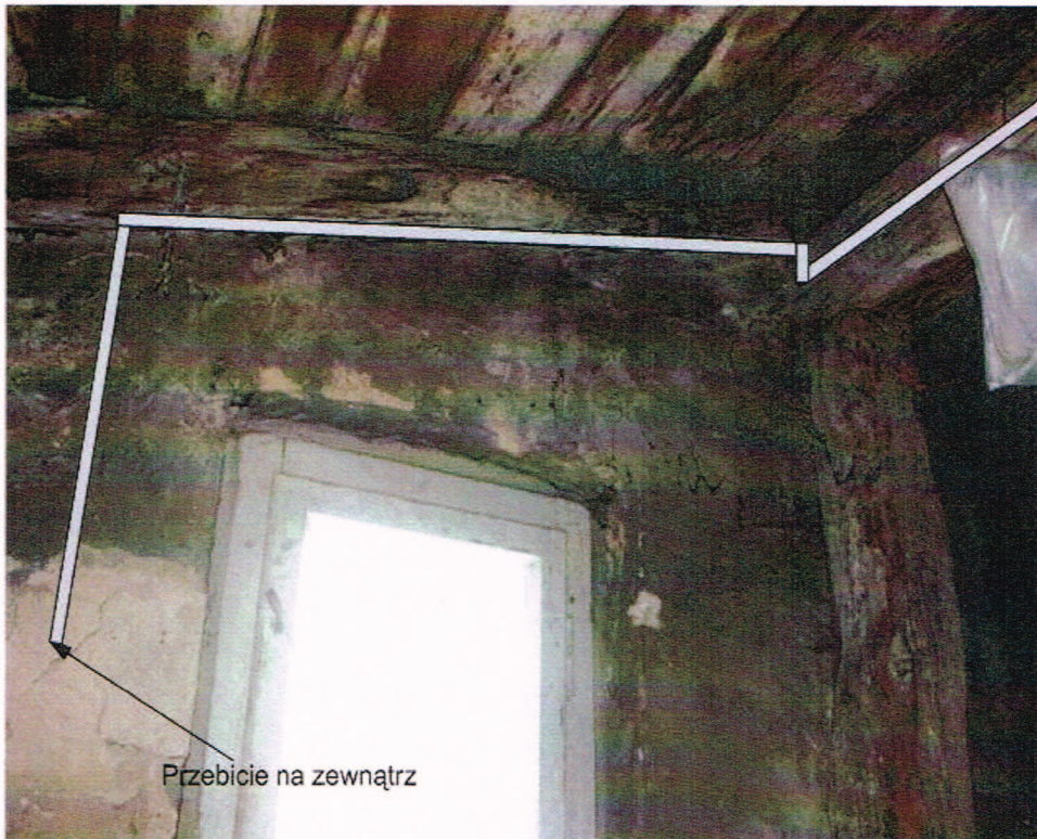
Rys. 48 Trasa kablowa do urządzenie abonenckiego WiMAX
