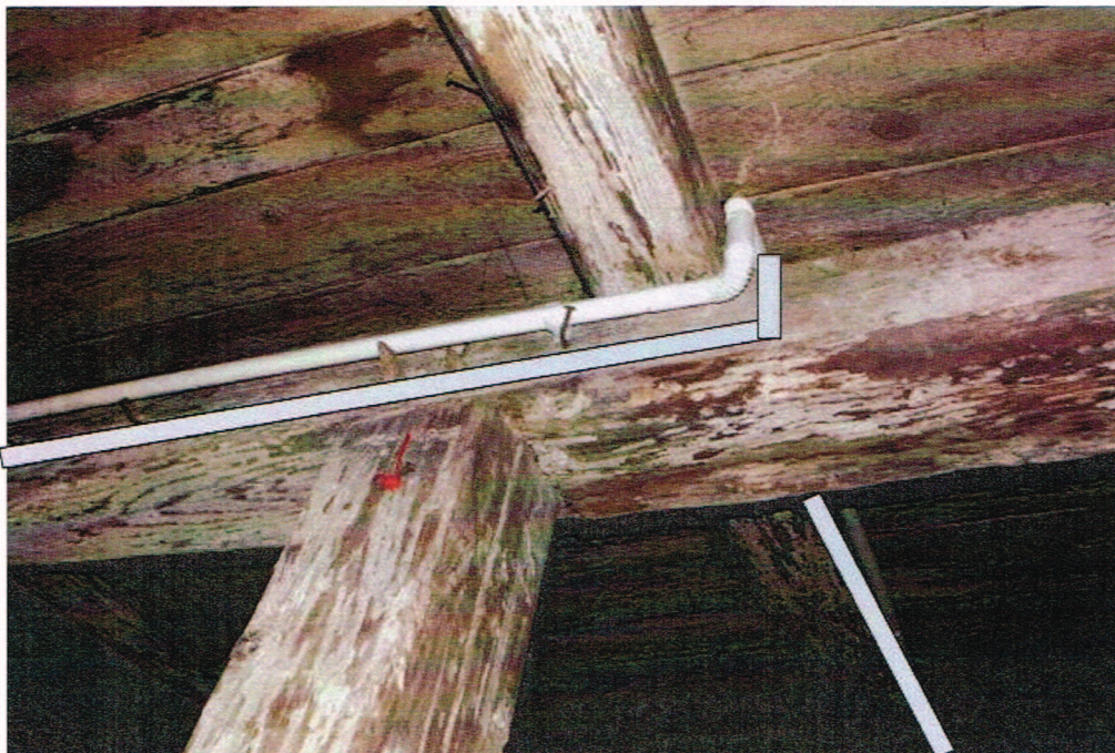
Rys. 46 Trasa kablowa do urządzenie abonenckiego WiMAX
