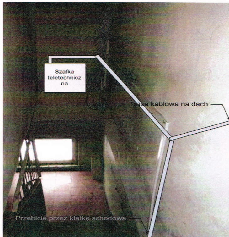
Rys. 31 Miejsce montażu szafki teletechnicznej i trasy kablowe do podlicznika energii elektrycznej i do urządzeń nadawczo odbiorczych systemu WiMAX i radiolinii
