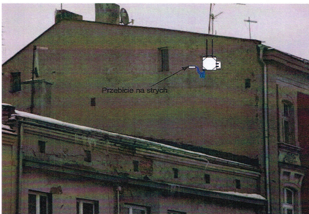
Rys. 49 Miejsce montażu urządzenia abonenckiego WiMAX
