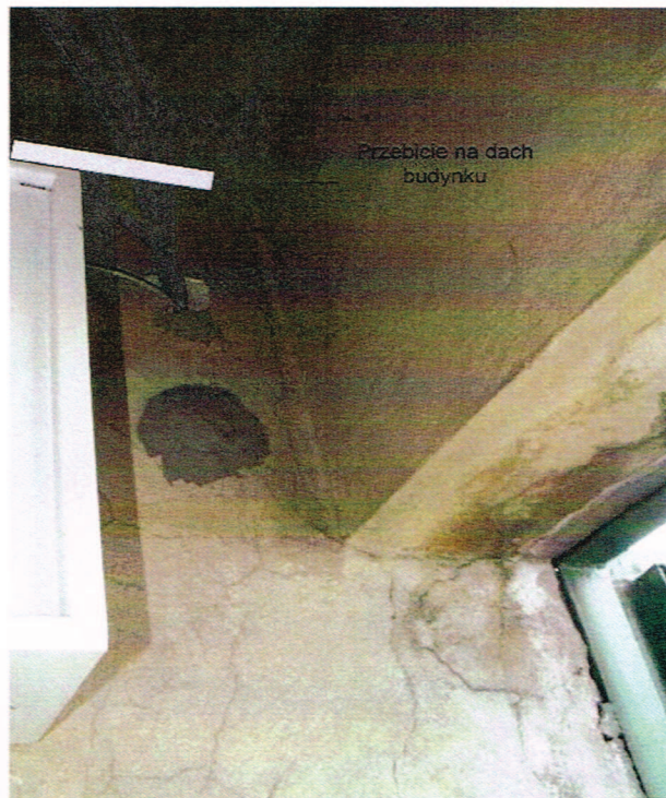
Rys. 15 Trasa kablowa na dach budynku
