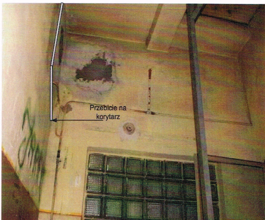
Rys. 12 Trasa kablowa do szafki teletechnicznej
