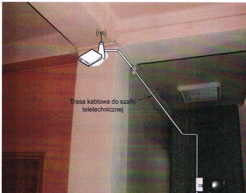
Rys. 57 Miejsce montażu routera WiFi
