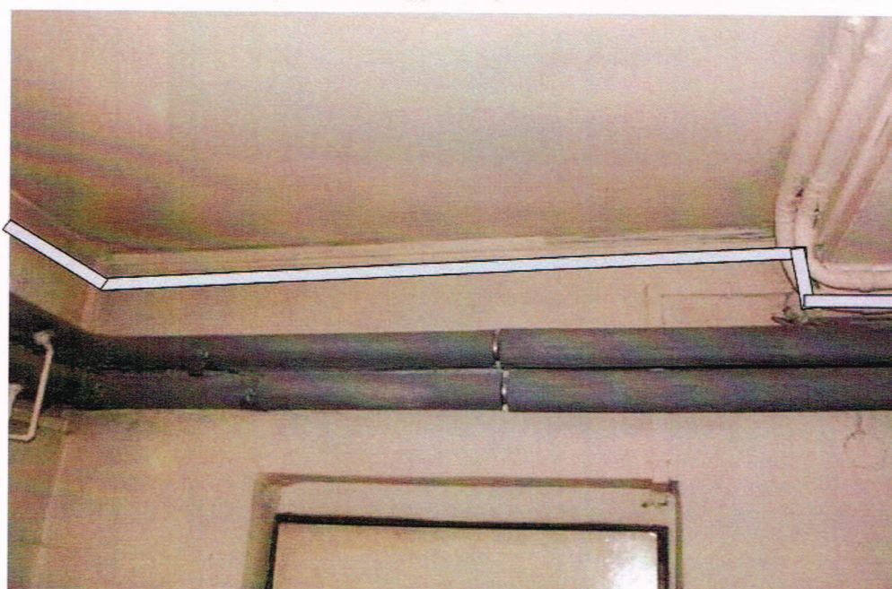
Rys. 4 Trasa kablowa do Infokiosku i routera WiFi
