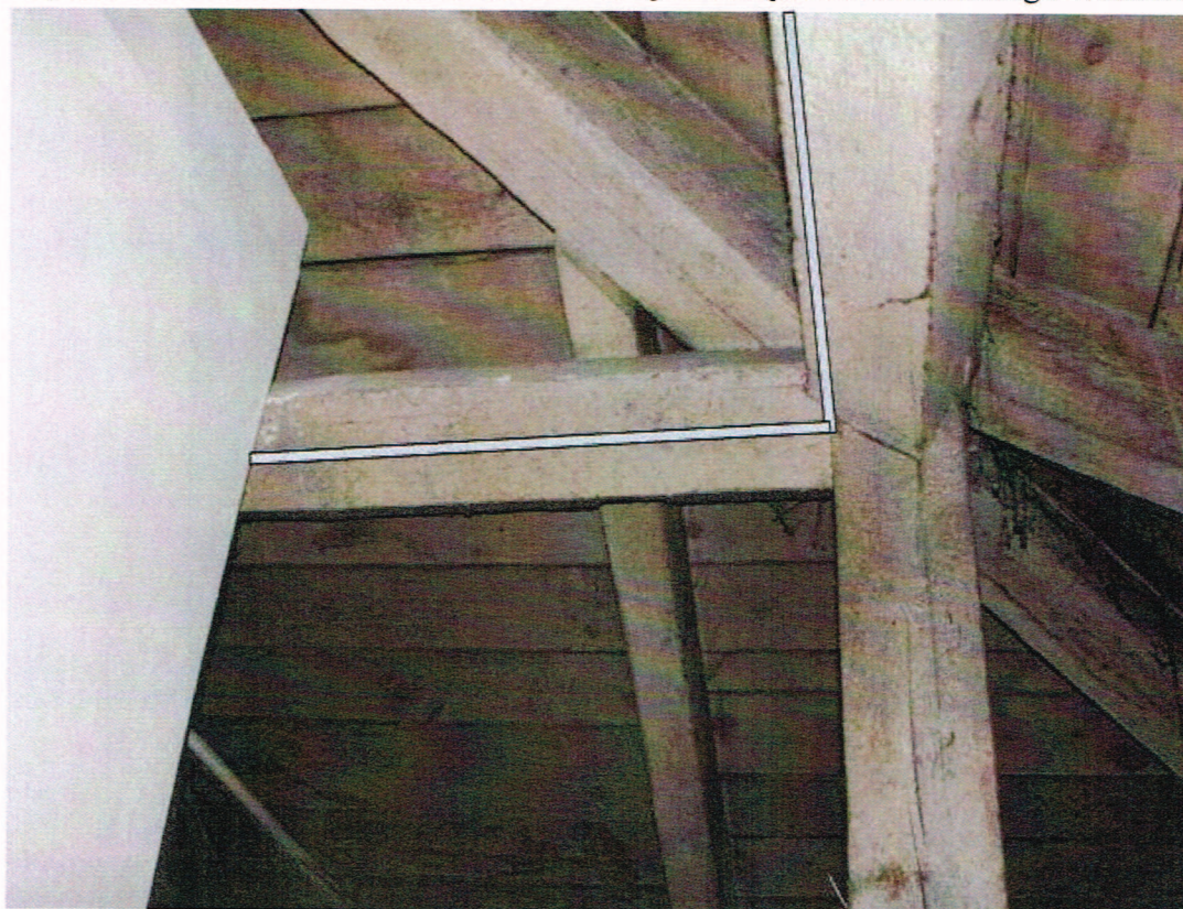
Rys. 96 Trasa kablowa z szafki teletechnicznej do urządzenia abonenckiego WiMAX
