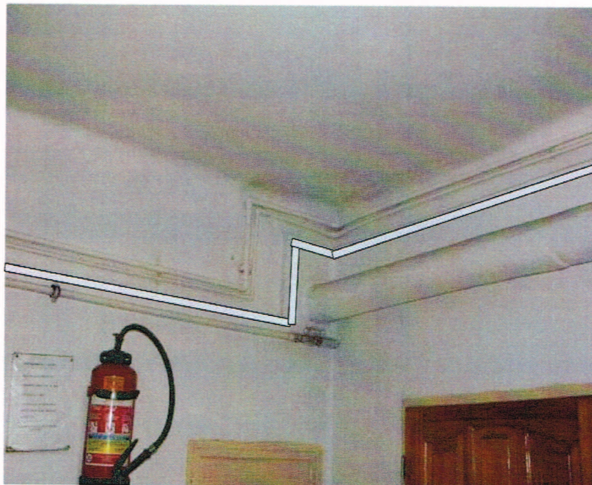
Rys. 100 Trasa kablowa z podlicznika do szafki teletechnicznej
