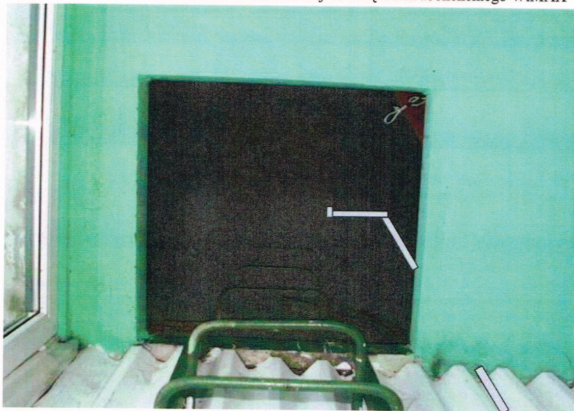
Rys. 118 Trasa kablowa z szafki teletechnicznej do urządzenia abonenckiego WiMAX
