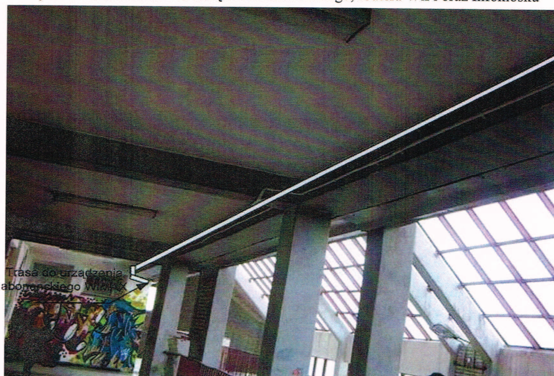
Rys. 72 Trasa kablowa do urządzenia abonenckiego oraz Infokiosku
