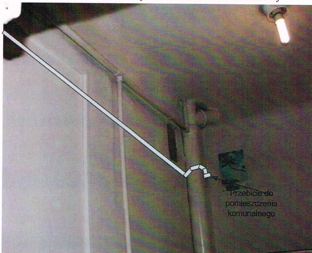
Rys. 104 Trasa kablowa z podlicznika do szafki teletechnicznej
