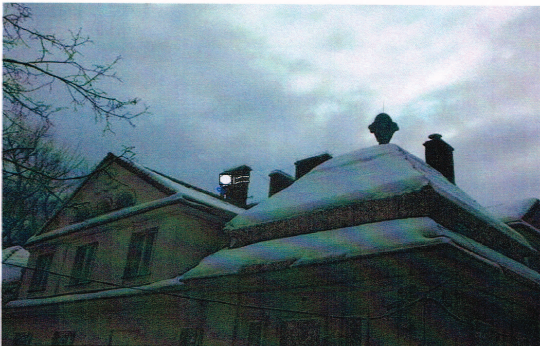
Rys. 66 Miejsce montażu urządzenia abonenckiego WiMAX
