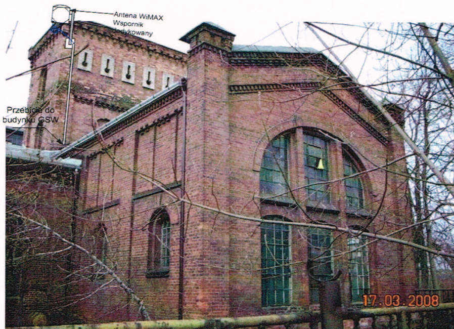
Rys. 88 Miejsce montażu urządzenia abonenckiego WiMAX i trasa kablowa z szafki teletechnicznej do urządzenia nadawczo-odbiorczego WiMAX
