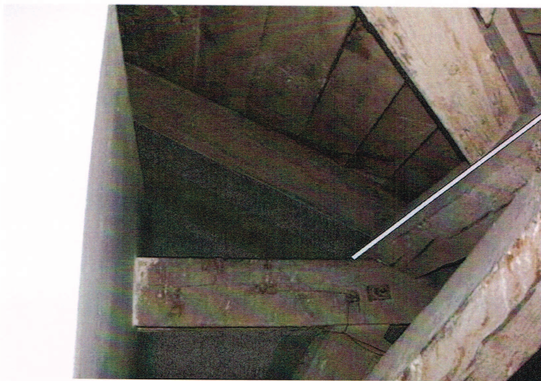
Rys. 95 Trasa kablowa z szafki teletechnicznej do urządzenia abonenckiego WiMAX
