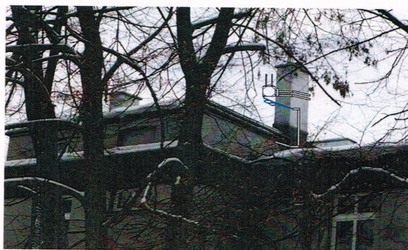
Rys. 124 Miejsce montażu urządzenia abonenckiego WiMAX
